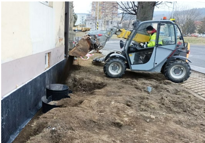
Osadenie vodomernej šachty, zateplenie budovy TS
