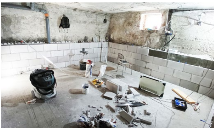
Rekonštrukcia pivnice - budova Technické služby
