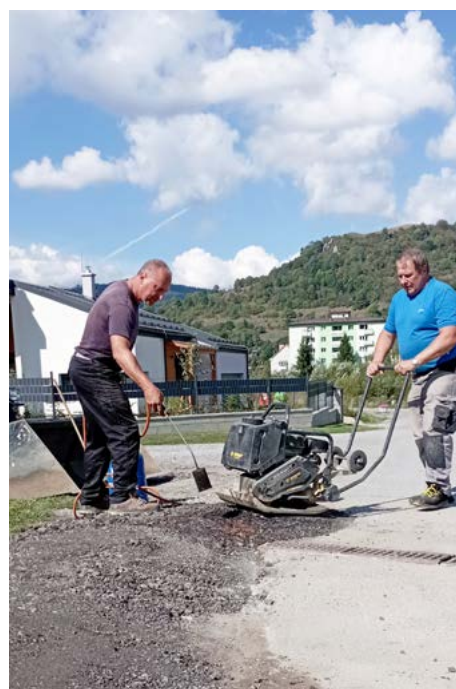
Oprava odtoku dažďovej vody
