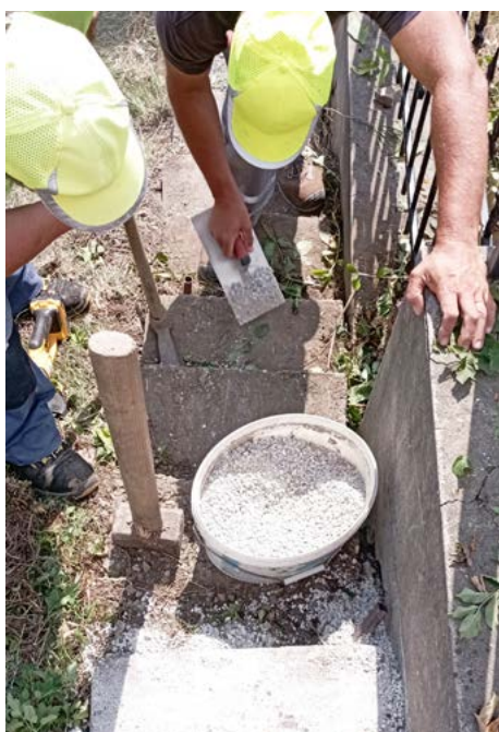
Oprava bočných schodov na cintoríne
