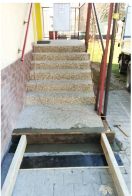
Oprava schodiska - zdravotné stredisko
