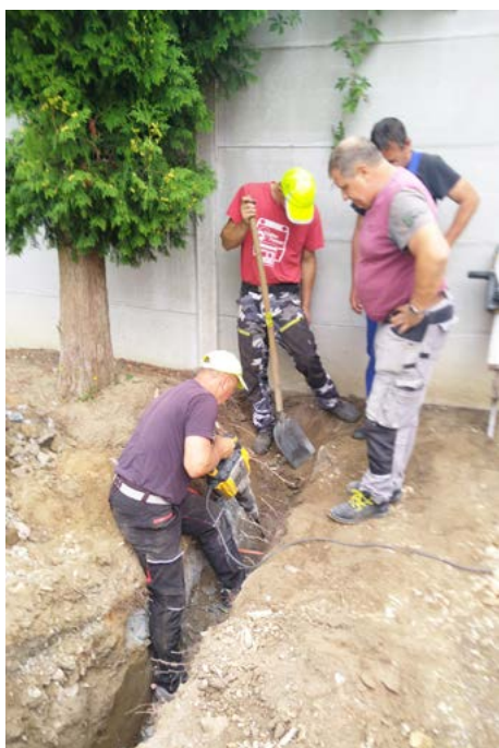
Prípravné práce na kanalizáciu - Dom seniorov
