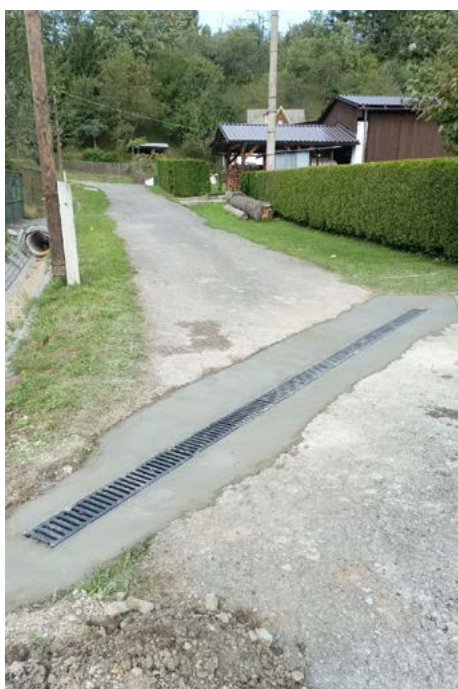
Vybudovanie odtokovej šachty Vintiška
