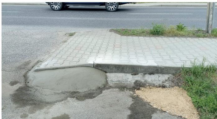
Oprava zámkovej dlažby na Hviezdoslavovej ulici
