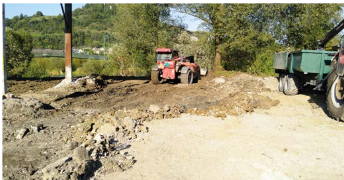
Odstránenie časti z oplotenía, vyrovnanie podkladu
