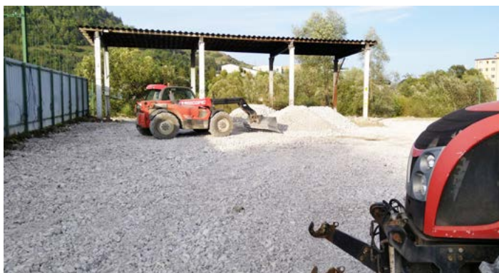
Zasýpanie podkladu pod spevnené plochy
