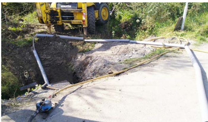
Stavebné práce k zriadeniu vodovodnej prípojky
