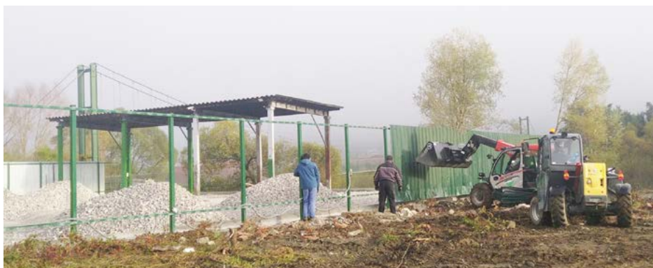
Odmontovanie plechu z pôvodného oplotenia a následné natretie konštrukcie vrchným syntetickým náterom
