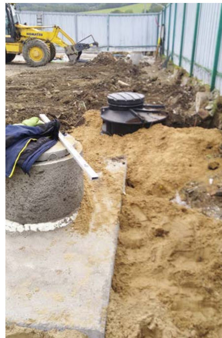
Osadenie kanalizačnej prípojky a žumpy
