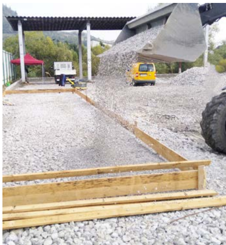
Prípravné stavebné práce pod cestnú váhu
