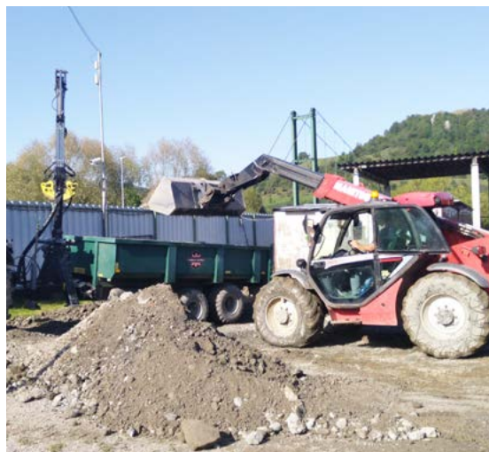
Vybratie a odvezenie pôvodného podkladu
