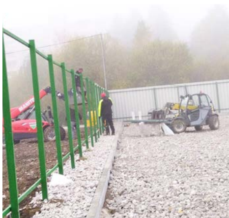
Namontovanie opláštenia z trapézového plechu
