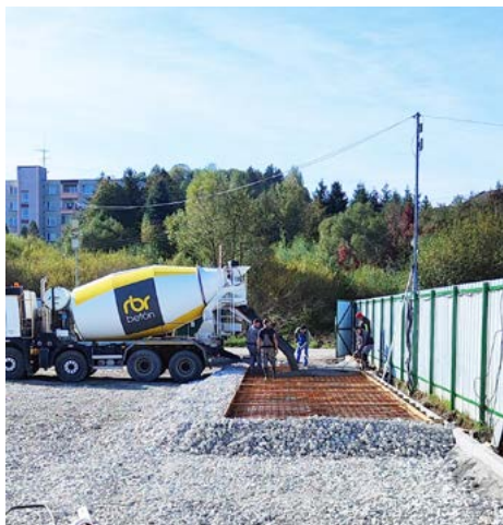
Zabetónovanie výstuže z ocelevej sieťoviny ako podklad pod cestnú váhu
