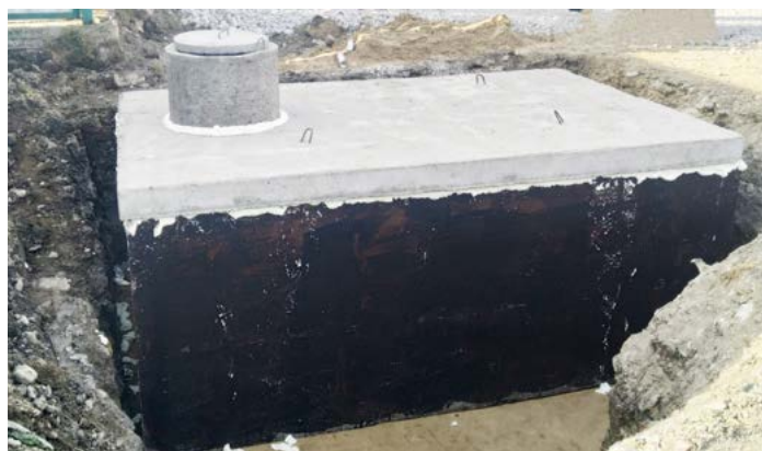
Osadenie prefabrikovanej žumpy
