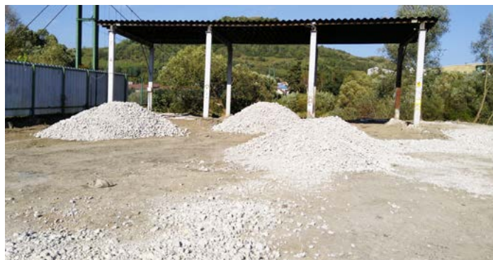
Príprava na zasýpanie podkladu pod spevnené plochy
