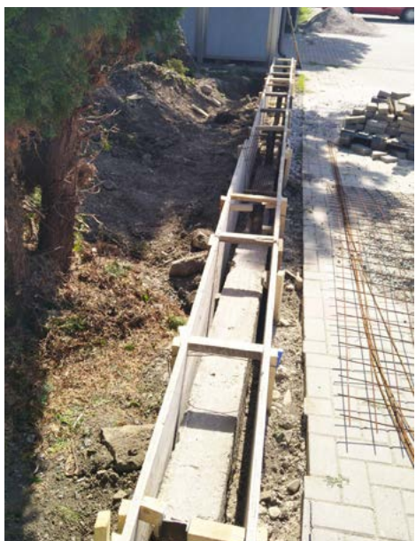
Betónové základy na plot
