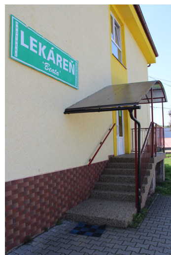
Rekonštrukcia schodiska do lekárne
