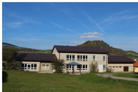
Výbudovanie strechy, výmena okien, dobudovanie pergoly, úprava interiérov, kúrenia, vybudovanie odvodnenia, osadenie altánku na MŠ Orliče
