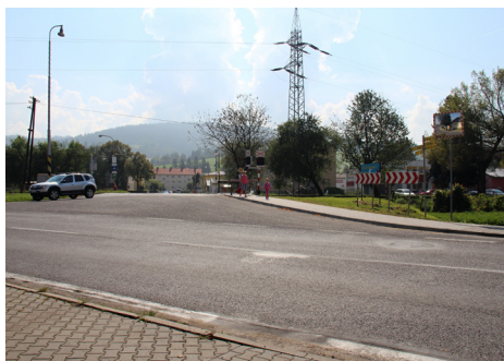
Výbudovanie chodníka pre peších cez železničné priecestie
