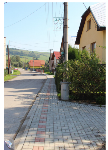
Dobudovanie chodníka pre peších s úpravou odvodnenia miestnej komunikácie v Zemianskej Dedine
