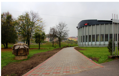
Výbudovanie nového chodníka pre peších a malé vozidlá okolo DK
