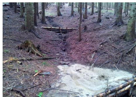
Výstavba protipovodňových stavieb, odvodňovacích rigolov, úpravy ciest a protipovodňových poldrov v Magure
