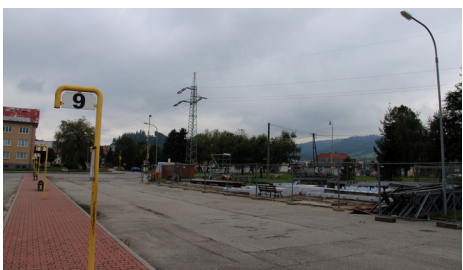
Demontáž prístrešku na autobusovom nástupišti
