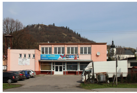
Výmena okien Domu služieb
