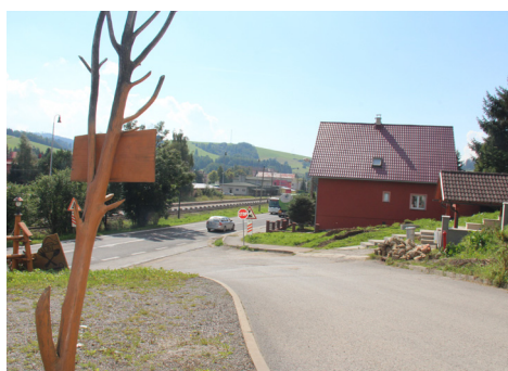
Dobudovanie chodníka na Krivé hony a príprava na kolaudáciu prístupovej cesty
