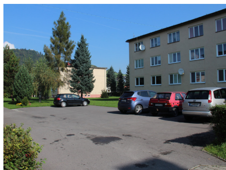
Výbudovanie parkoviska s odvodnením pri bytovke č. 464
