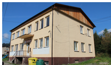
Výbudovanie novej strechy a výmena okien v DK Zemianska Dedina
