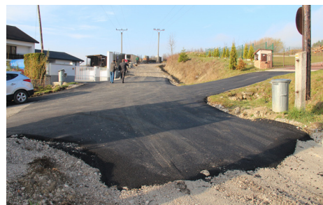
Oprava križovatky a odvodnenie miestnej komunikácie Vintiška
