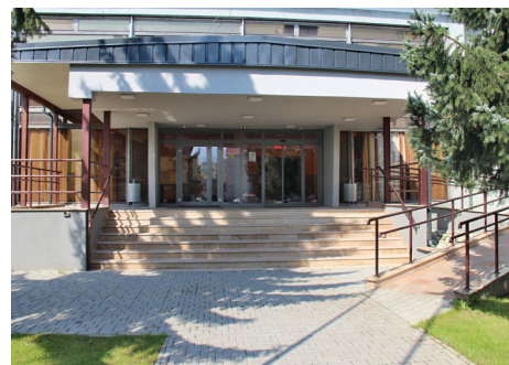
Výbudovanie nového vchodu, nových schodov a bezbariérového prístupu so zastrešením na OcU
