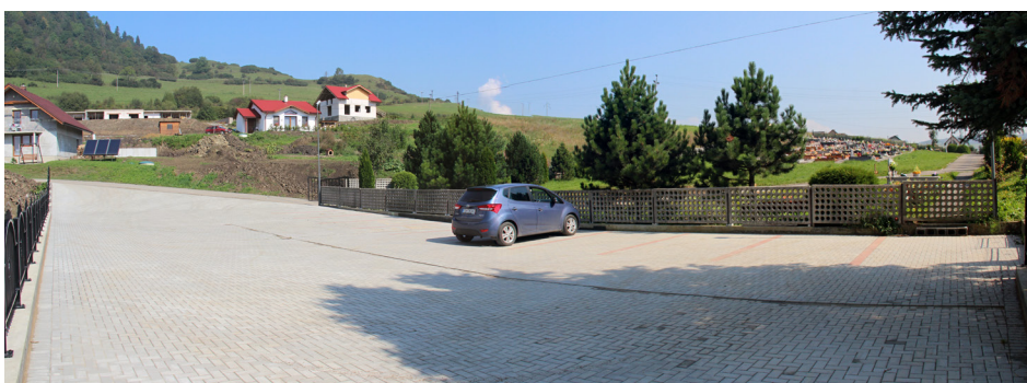
Výbudovanie parkoviska s vysporiadaním pozemkov na prístupovej ceste k cintorínu a dobudovanie časti odvodnenia cintorína
