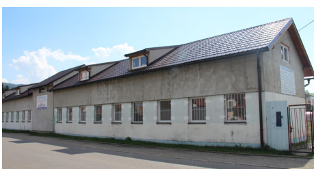
Výmena okien na budove štadiónu, vytvorenie nového chráneného pracoviska pre občana so zdravotným postihnutím
