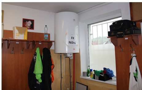
Výmena bojlerov a rekonštrukcia elektrických rozvodov v budove štadiónu
