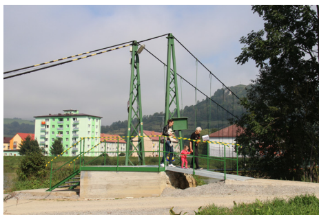
V rámci projektu KIA Motors, vybudovanie bezbariérového prístupu na lanový most za základnou školou a komplexná rekonštrukcia lanového mostu. Výstavba miestnej komunikácie v tejto lokalite
