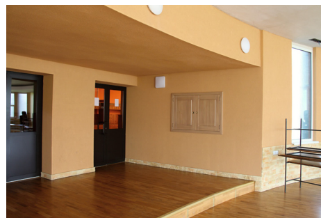
Rekonštrukcia interiéru Rotundy - výmena elektroinštalácie, výmena okien, vnútorné zateplenie s povrchovou úpravou, rekonštrukcia osvetlenia s použitím úspornej technológie LED
