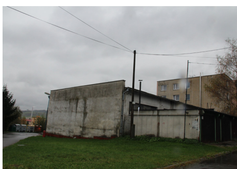
Počas čítania novín už bude realizovaná komplexná rekonštrukcia strechy starej kotolne na Malej Orave
