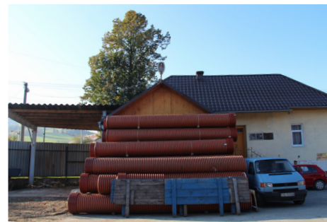
Výbudovanie prístrešku na technických službách
