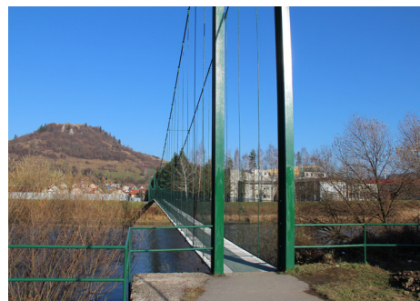
Komplexná rekonštrukcia lanového mostu na Malú Oravu
