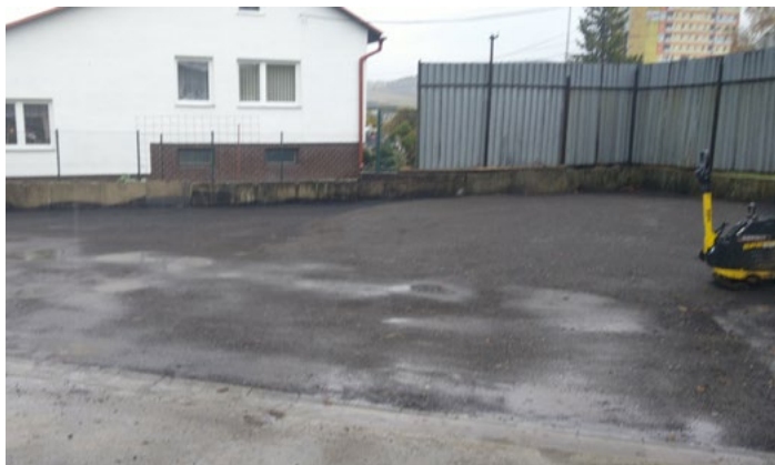
Úprava parkovacej plochy - Technické služby Nižná
