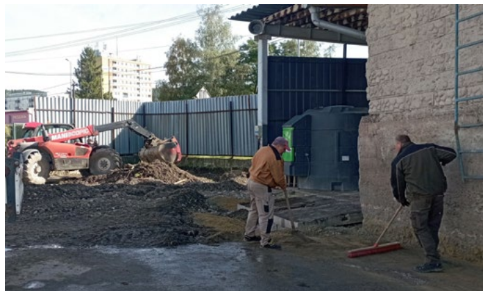
Úprava areálu Technických služieb Nižná
