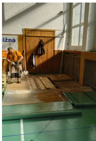
Oprava podlahy v telocvični ZŠ s MŠ
